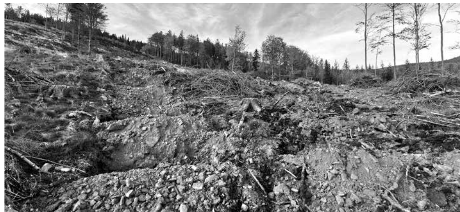
6) Hloubka zasakovacích jam a šířka stabilizačních hrázek se odvíjí od sklonu terénu. Čím je prudší svah, tím jsou jámy hlubší a hrázky širší. U zasakovacích pásů může být vryp bagru hluboký až 1,5 m. Dešťová voda se v jámách neakumuluje, ale okamžitě vsakuje hluboko do země.
